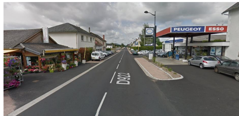
Secteur de la D922 à Lanobre. Cliché : Google Maps
